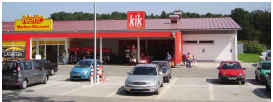
Das unter der Bezeichnung Easyclick 38 vertriebene Snapfalz-System sorgt auf der 2000 m 2 großen Dachfläche für Sicherheit. Die verzinkten und beschichteten 17 m langen Bahnen haben eine Baubreite von 505 mm
